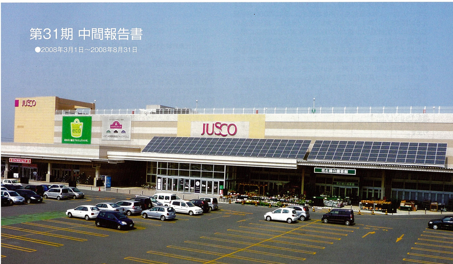
新たに壁面にソーラーパネルを設置したエコストア、イオン苫小牧SC
