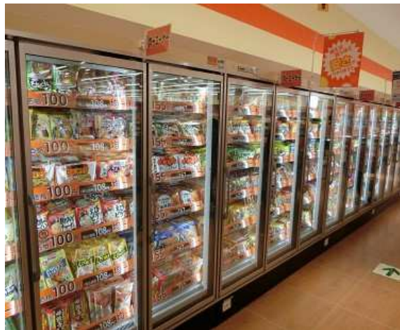
冷蔵・冷凍ケース更新
